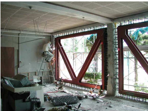
セメントカプセル施工状況(学校耐震補強)
