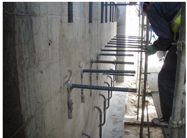
セメントカプセル施工状況(新幹線橋脚補強)
